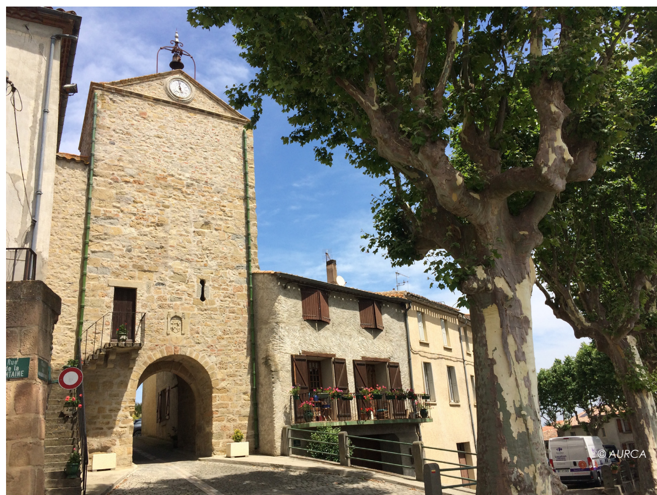
Porte fortifiée dite de Pépi, Aaligne
